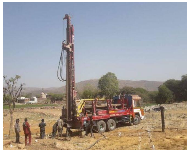
Auf 100 m Tiefe auf Quelle gestossen
