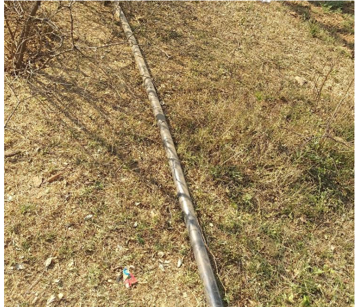
Die Leitungen sind verlegt. Bald fließt das Wasser
